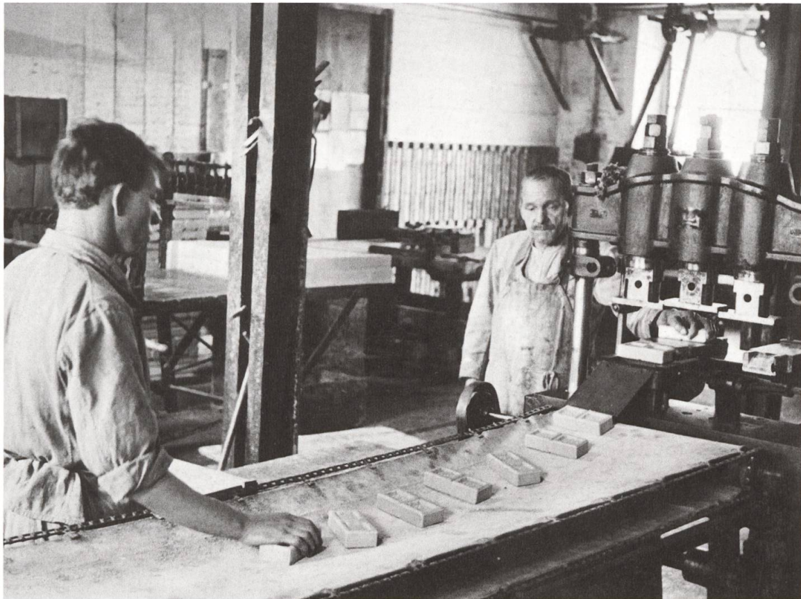
9 Im Walzwerk wird die Mischung homogenisiert, dann in der Strangpresse zum Endlosstrang vorgeformt. Daraus werden die gleichmässigen Stücke, die Rohlinge, geschnitten. Noch in warmem Zustand werden diese zur endgültigen Form gepresst.
