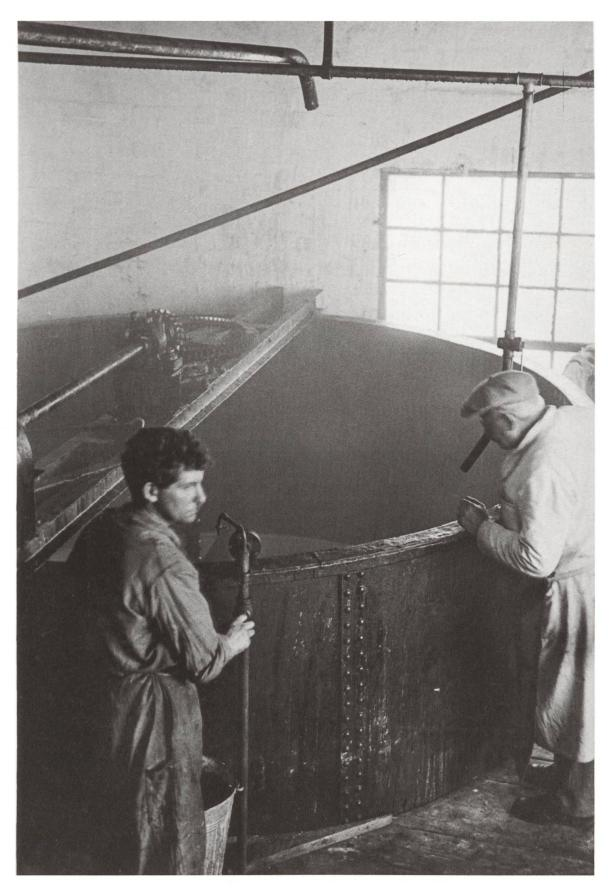
6 Für die Herstellung der «Kronenseife», der hauseigenen Kernseife, werden in der Siederei zunächst mehrere Tonnen Fett mit der richtigen Menge Natronlauge im offenen Kessel drei Tage lang gekocht. Eine direkte Dampfeinspritzung dient der Erhitzung. Durch Zugabe von Kochsalz wird die Seife aus der Lösung herausgedrückt (ausgesalzen), sodass sie auf der Unterlauge aufschwimmt.
