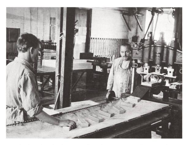
9 Im Walzwerk wird die Mischung homogenisiert, dann in der Strangpresse zum Endlosstrang vorgeformt. Daraus werden die gleichmässigen Stücke, die Rohlinge, geschnitten. Noch in warmem Zustand werden diese zur endgültigen Form gepresst.
