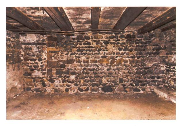
8 Klingnau-Goldgässli. Kernbauzeitliches Mauerwerk aus dem 13. Jh., teilweise im Ährenverband aufgemauert (Kgn.017.1).
