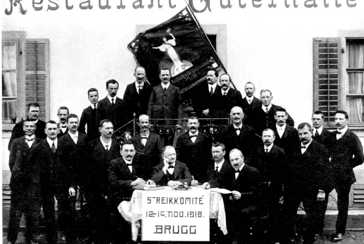
1 Das versammelte Streikkomitee Brugg posierte zum Abschluss des Landesstreiks und reklamierte mit einer roten Vereinsfahne das Restaurant Güterhalle für sich (SozArchZH F 5070-Fx-002).
