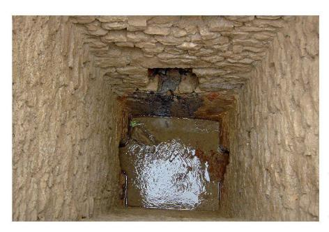
Abb. 5: Windisch. Spektakulärer Blick in die Tiefe eines Kontrollschachts der laufenden römischen Wasserleitung.
