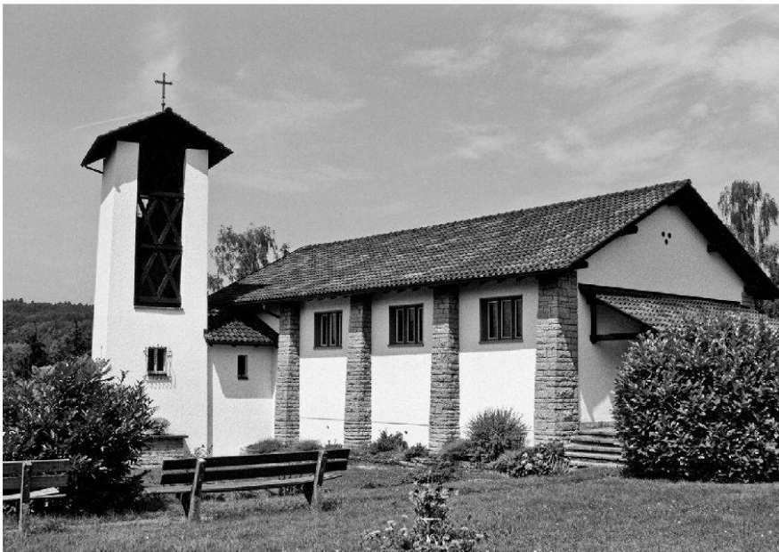
Römisch-katholische Bruderklausen-Kapelle in Etzgen, Architekt: Walter Bossard, erbaut 1948, Aussenansicht (Foto: Kantonale Denkmalpflege, Aargau).
