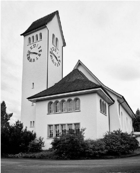
Reformierte Kirche in Frick, Architekten: Vischer & Sohn, erbaut 1908–1910, Aussenansicht (Foto: Kantonale Denkmalpflege Aargau, Aufnahme von Anke Köth).
