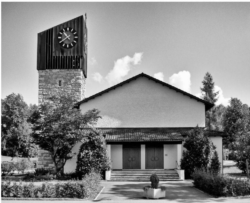
Römisch-katholische Kirche Guthirt in Aarburg, Architekt: Otto Dreyer, erbaut 1941/42, Aussenansicht (Foto: Kantonale Denkmalpflege Aargau, Aufnahme von Anke Köth).
