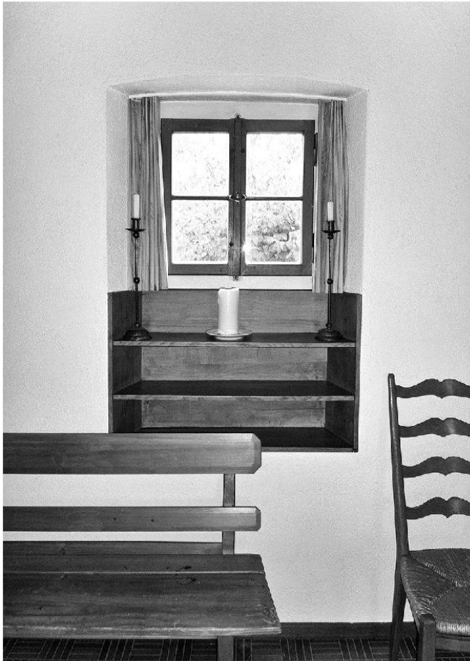
Reformierte Kirche in Buchs, Architekten: Alfred und Heinrich Oeschger, erbaut 1949/50, Detail (Foto: Kantonale Denkmalpflege Aargau, Aufnahme von Anke Köth).
