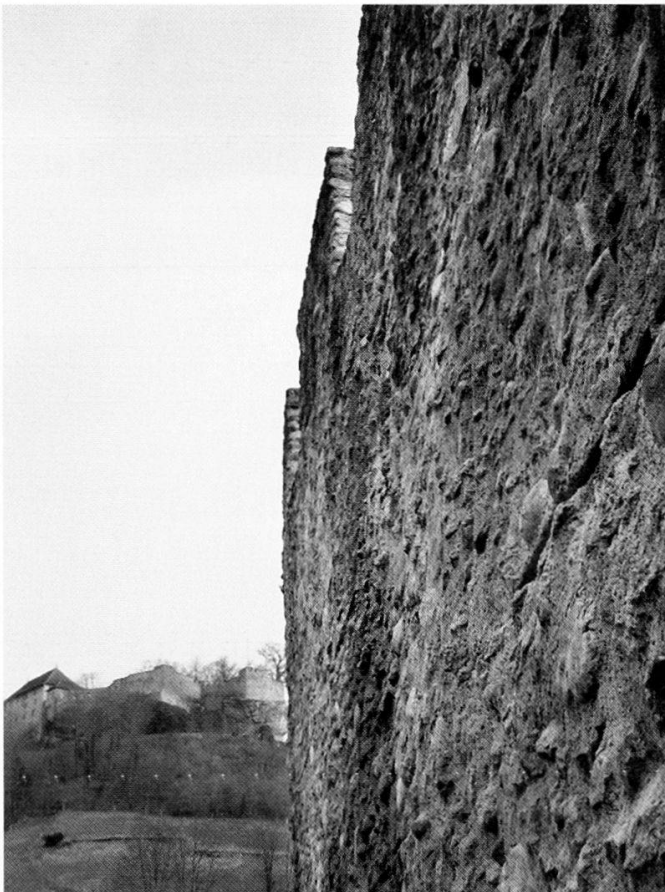
Erst im 13. Jahrhundert wurden Ringmauern im Aargau üblich. Lenzburgs neue Mauern wurden 1387 von 5,1 m auf 8,3 m aufgestockt, unruhige Zeiten kündigten sich an. (Bild: A. M. Rückert)
