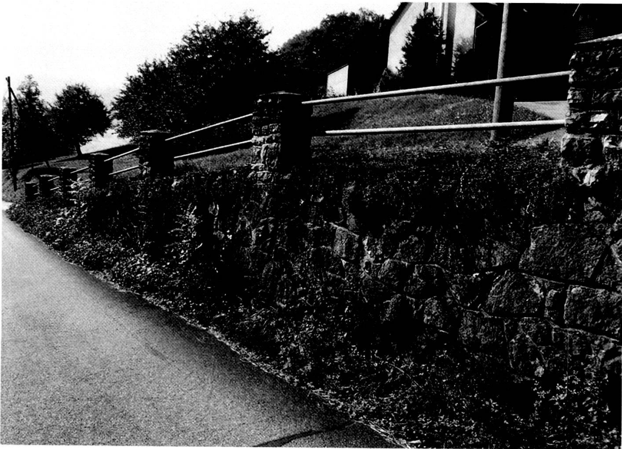
Zusätzlich zur Strasse bauten die Polen auch Stützmauern. C. B., 2005.
