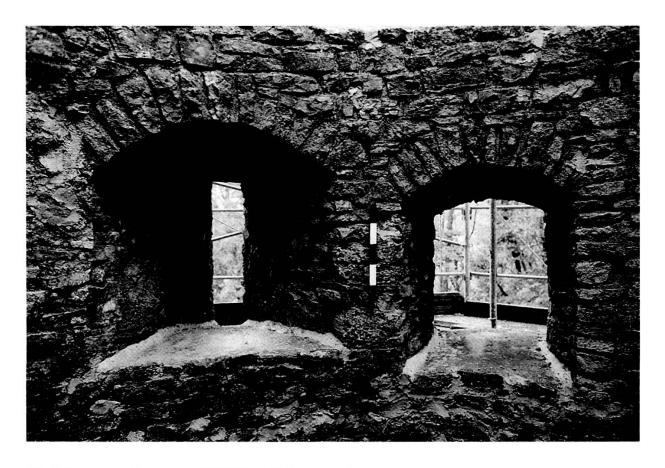
37 «Pulverturm» – Rundturm M28 2003, 1935 rekonstruiertes Schartenfenster (links) und Schlüsselscharte ohne Leibung (rechts) im 1. Obergeschoss, von Norden (KAAG).
