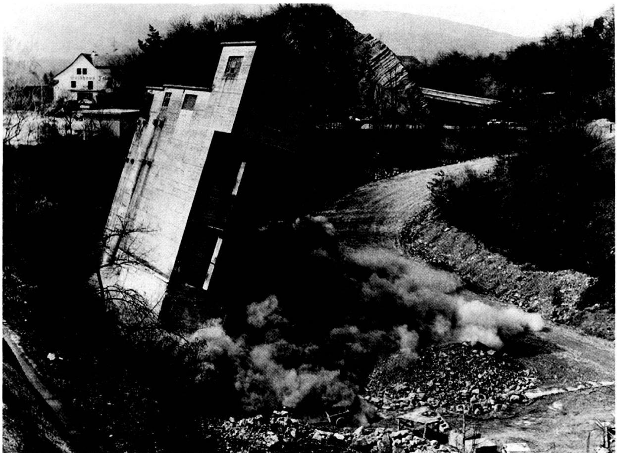
Luftschutzrekruten sprengten am 17. April 1984 das alte Silogebäude im Holderbanker Steinbruch.
