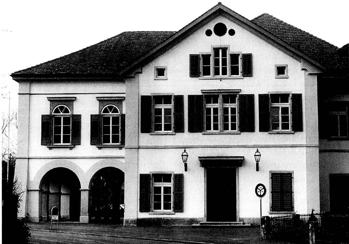
Abbildung 41 a: Alter Gemeindesaal. In der Mitte der Altbau von 1843, links der Anbau von 1863/64
