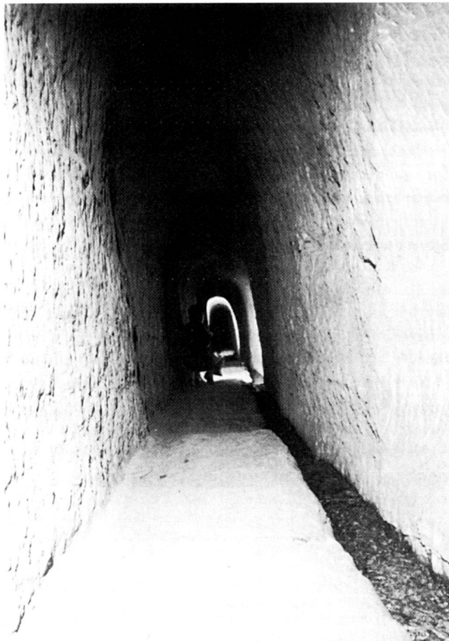
Abbildung 28 b: Tunnelbau 1860. Der Stollen ist 300 m lang mit Gehweg und seitli- cher Rinne für das abfließende Quellwasser (die hellen Tunnel- abschnitte sind Aufnahme-Blitz- lichter)
