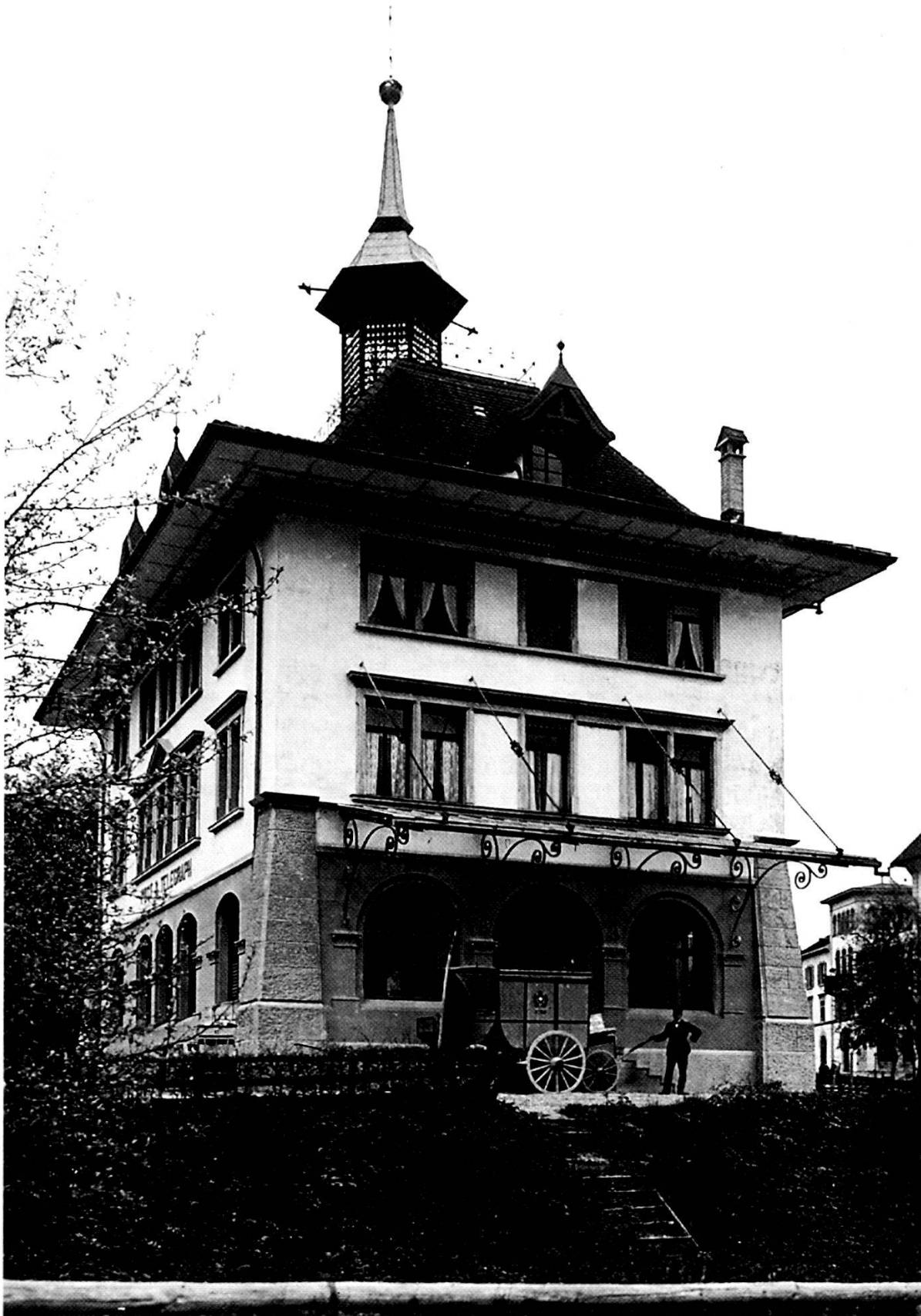
Abbildung 23b: Am 1. Oktober 1899 wurde das neue Postgebäude bezogen. Das Isolatorentürmchen wurde 1933 abgebrochen
