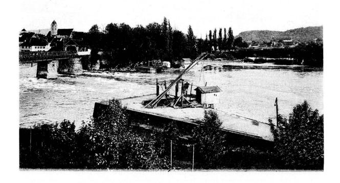
Abb. 27: Die Salmenwaagen unterhalb der Rheinfelder Brücke: Im Vordergrund die Glaser'sche Waage auf der badischen Seite, eine der massivsten dieser Gegend; die ganze Einrichtung ruhte auf einem aus Pfählen, Balken und Brettern künstlich geschaffenen Inselchen, so dass die Schiffe in ihrer Talfahrt nicht behindert waren. (Postkarte im Besitz des Verfassers.)
