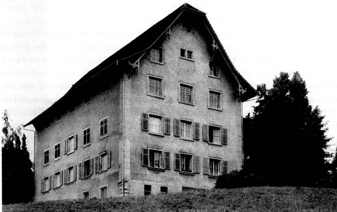
Abbildung 19 Gerichtsgebäude heute (Photo: Denkmalpflege des Kantons Aargau)
