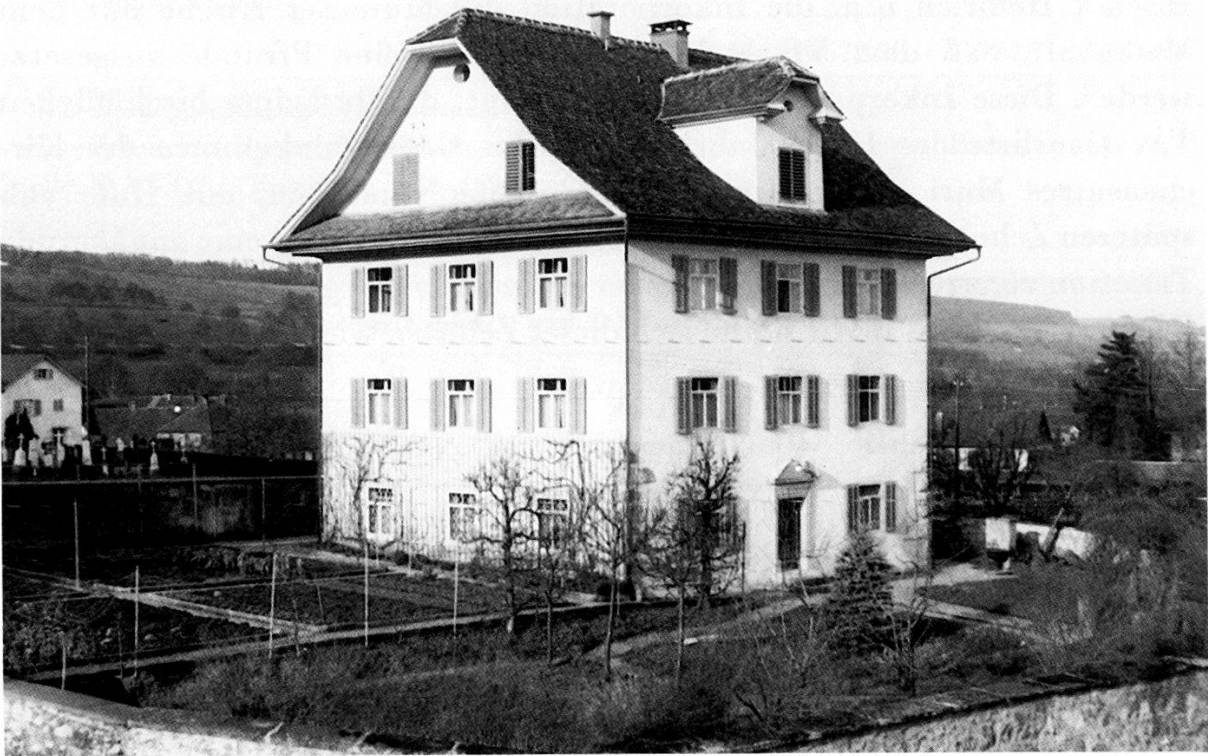
Abbildung 10 Pfarrhaus Muri heute (Photo: Denkmalpflege des Kantons Aargau)
