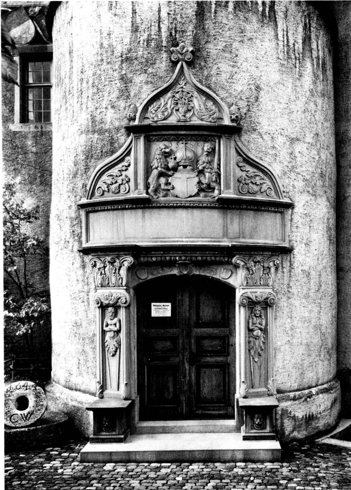
Das renovierte Portal des Landvogteischlosses Baden, 1580
