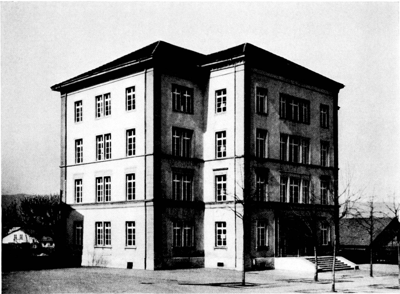
Abb. 43. Das zweite Schulhaus, 1854 für die Gemeinde- und Bezirksschule erbaut
