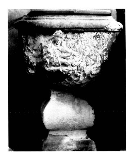
Abb. 3. Molassesandstein von geringer Kornbindung Absanden verursacht durch aufsteigende Grundfeuchte Kirche Beinwil im Freiamt, 1619. Photo: G. GERMANN
