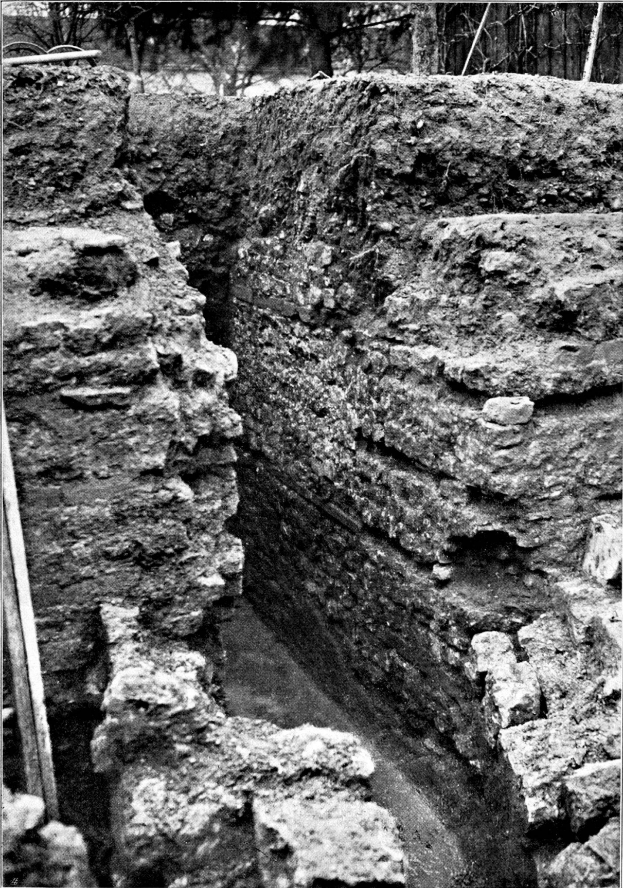
Der große Süd-Nordkanal, bei der Einmündung in die Wasserkammer, mit angebauter mittelalterlicher Fortsetzung (im Vordergrund). Aufnahme 1907.
