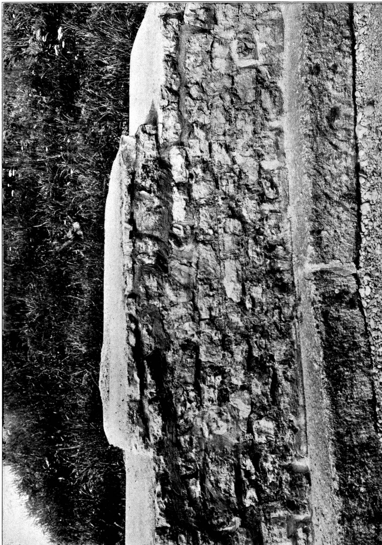
Ein Ausschnitt der unberührten Mauer am Westeingang des Amphitheaters, mit vertieftem Fugenstrich.
