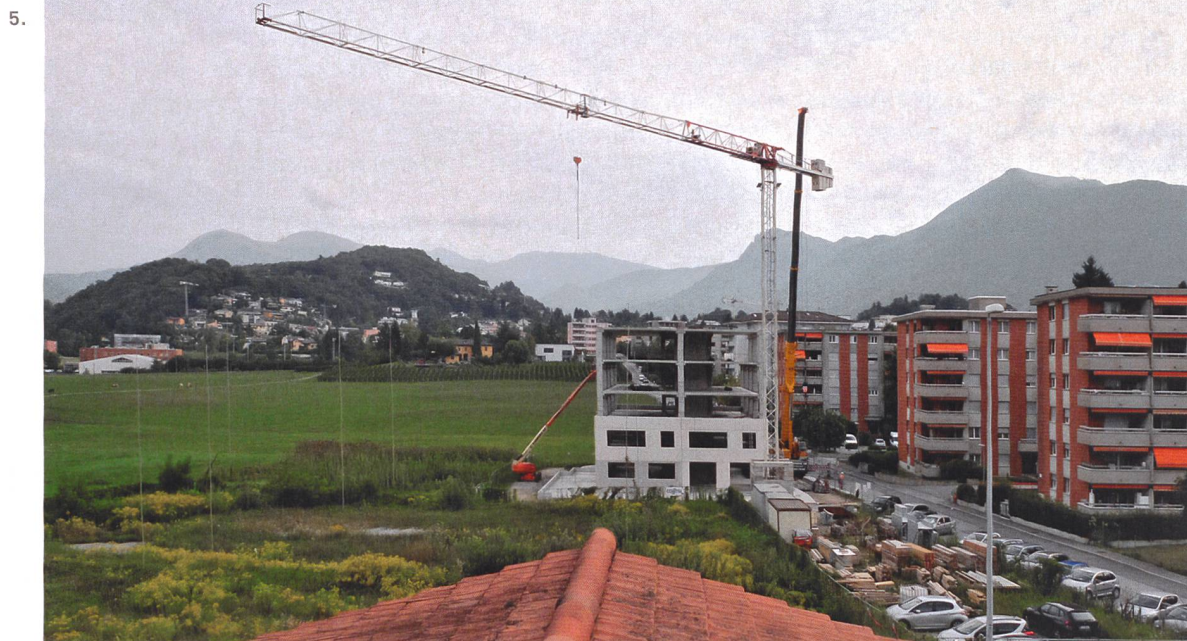
5. La distruzione del Pian Povrò è iniziata: l'edificio in costruzione, 1 settembre 2015. Foto Paolo Fumagalli
