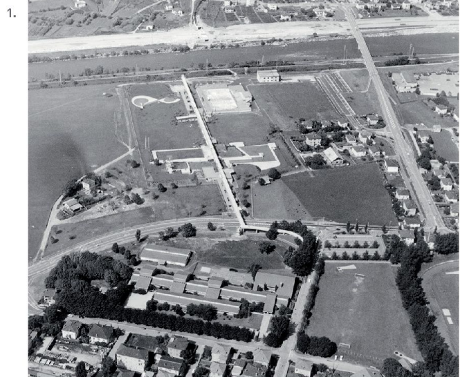
1. Aurelio Galfetti, Flora Ruchat e Ivo Trümpy, foto aerea Bagno pubblico comunale, Bellinzona, 1967-1970. Foto archivio privato Aurelio Galfetti, Lugano
