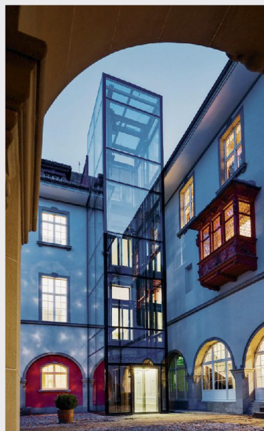
Il Museo storico ed etnografico di San Gallo: Il vano ascensore vetrato crea un moderno contrasto con l'edificio storico.
