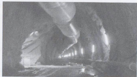
Cunicolo di aggiramento: scavo
