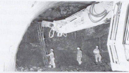
Cunicolo di aggiramento: scavo
