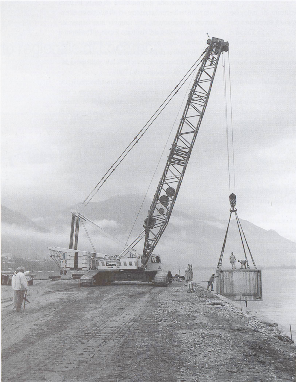
Varo di un elemento del molo frangionda
