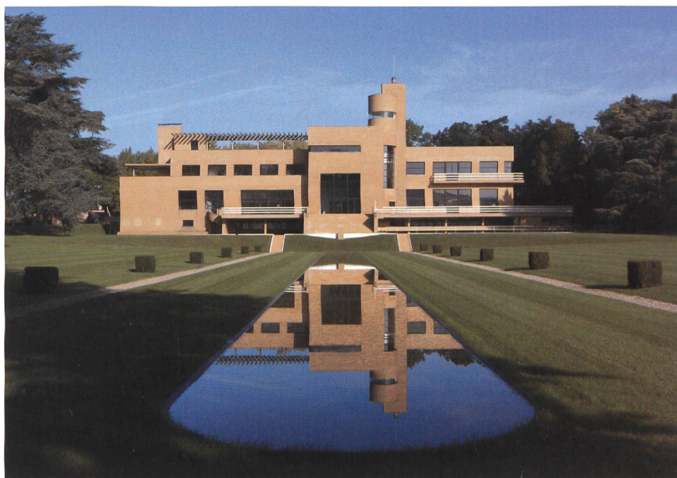
1. Robert Mallet-Stevens, Villa Cavrois, Croix, 1932. Facciata sud (© Robert Mallet-Stevens - ADAGP © Jean-Luc Paillé - Centre des monuments nationaux)
