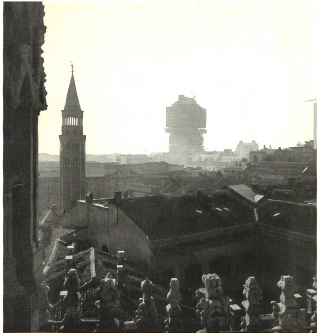
1. Torre Velasca in costruzione, dall'opuscolo pubblicitario della Società Generale Immobiliare, Alinea, Firenze, 1999
