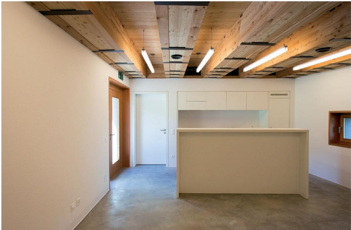
La struttura del solaio in legno è disposta longitudinalmente all'edificio per consentire l'installazione delle condotte dell'impianto di ventilazione-riscaldamento.
