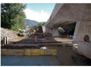
spetto alla linea ferroviaria e garantendo in tal modo una distanza sufficiente dal corso d'acqua. In testa, la sezione delle pile è invece rettangolare ed è allineata con l'impalcato. Le pile sono quindi disegnate come un corpo a 8 facce triangolari e subverticali.
