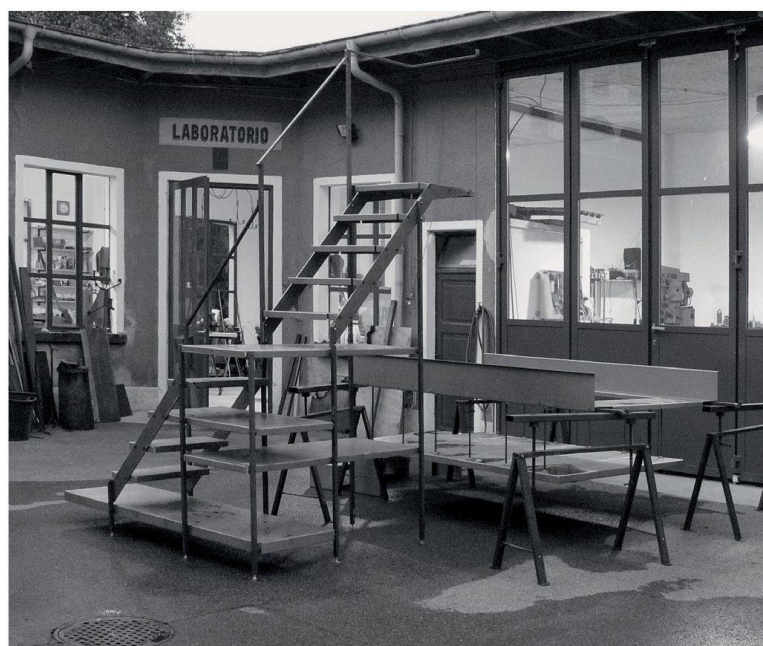
1. Il laboratorio di via Vela a Bellinzona. In primo piano il soppalco Fernando in fase di premontaggio
