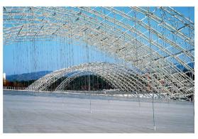
Ampia costruzione in acciaio con struttura a traliccio: discarica per rifiuti speciali SMDK, Kölliken. Impresa totale: ARGE SMDK Infra – Marti/Züblin –; progettazione costruzione in acciaio: Züblin Stuttgart. Foto: SMDK Kölliken
