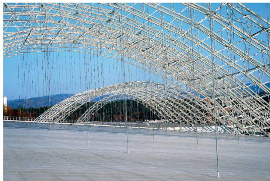
Ampia costruzione in acciaio con struttura a traliccio: discarica per rifiuti speciali SMDK, Kolliken. Impresa totale: ARGE SMDK Infra – Marti/Züblin –; progettazione costruzione in acciaio: Züblin Stuttgart. Foto: SMDK Kolliken
