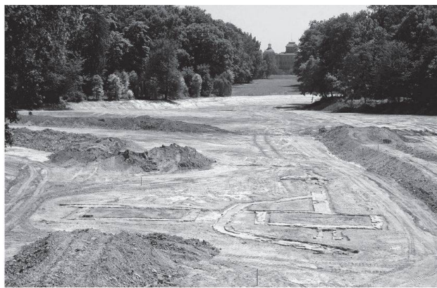
4. Alla fase di studio e di predisposizione del modello numerico è seguita l'azione di cantierizzazione vera e propria che ha comportato una ridefinizione pressoché totale delle pendenze e delle sezioni e una considerevole movimentazione di materiale solido sedimentato. Inoltre, durante i lavori, si sono rese necessarie modifiche al progetto a seguito del ritrovamento di preesistenze legate al periodo barocco e lenotriano del parco. Il modello si è dunque arricchito di nuove caratteristiche legate alla memoria, segnalazione e conservazione di manufatti e strutture. Foto A. Longo e P. Cavagnero**
