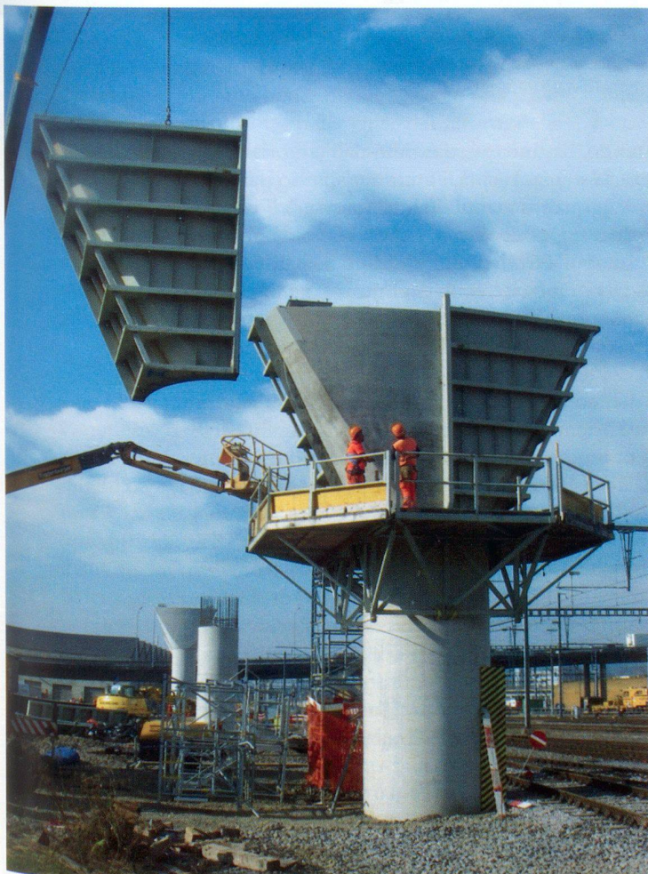
Operazioni di scasseratura del capitello di una pila e, a destra, vista trasversale su pila e sezioni a geometria variabile su pila, capitello e appoggio
