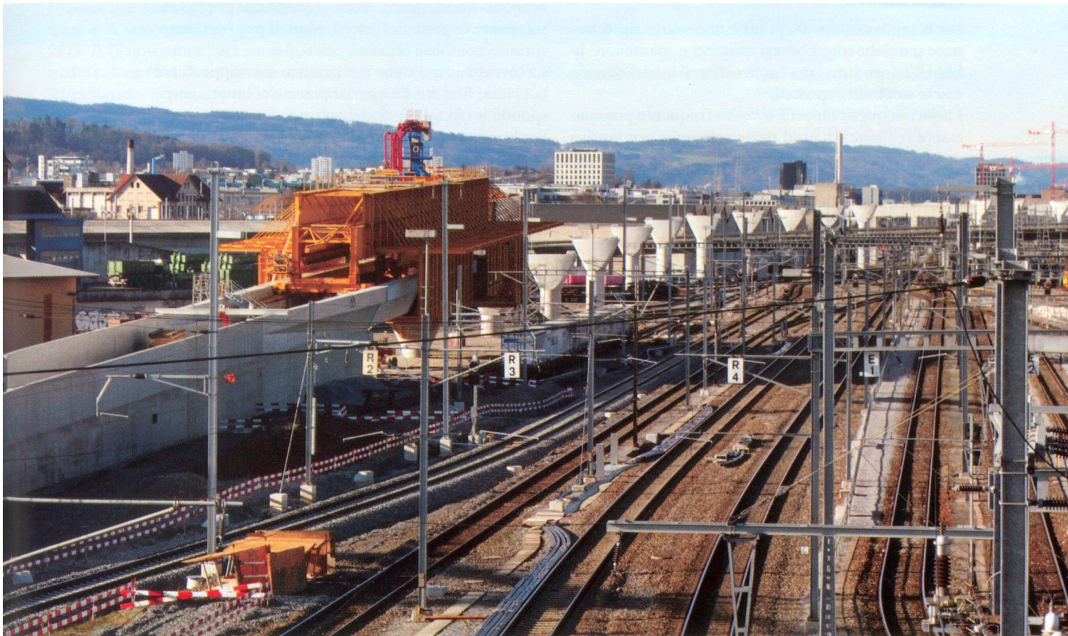
Trave autovarante sulla rampa del viadotto Kohlendreieck e vista sulla sequenza delle pile
