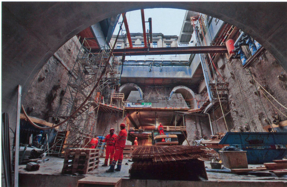
L'imbocco della galleria del Weinberg, all'estremità est della stazione. Vista dall'interno della galleria verso ovest, in direzione della stazione Löwenstrasse. Le due gallerie al centro della fotografia fungono da sostegno per la realizzazione della calotta che regge il tratto sud della stazione esistente.
