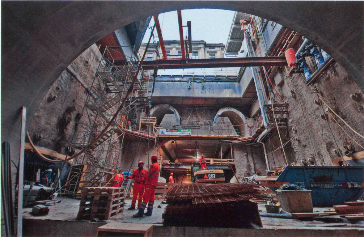
L'imbocco della galleria del Weinberg, all'estremità est della stazione. Vista dall'interno della galleria verso ovest, in direzione della stazione Löwenstrasse. Le due gallerie al centro della fotografia fungono da sostegno per la realizzazione della calotta che regge il tratto sud della stazione esistente.
