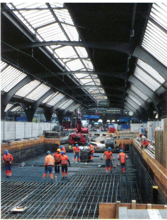
Fase di getto della calotta sotto le volte dei binari Foto Judit Solt
