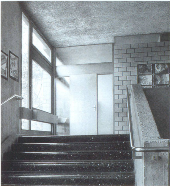
Scuola di Palettes (1964-1968) a Grand-Lancy. La modulazione verticale di 15 cm ordina la posizione e le dimensioni di tutta la pianificazione interna: cassettoni e traverse delle finestre, panche e cornici dei guardaroba, ecc. Sul soffitto, la modularità senza interruzione dei pannelli Perfecta (50 x 200 cm) segue la disposizione a mulinello della pianta; l'incrocio dei due moduli di 55 cm è marcato da un cubo di cemento sospeso. L'illuminazione artificiale – lineare nei locali d'insegnamento, puntuale negli spazi di distribuzione e nelle nicchie dei guardaroba – è sempre disposta lateralmente, mai nel soffitto. Foto Pavel Cugini
