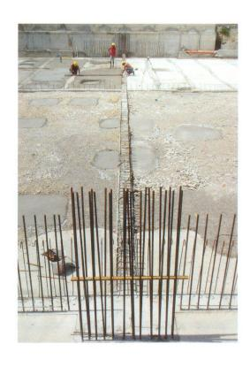
Le forcelle sono state prefabbricate in cantiere e posate mediante autogru nei rispettivi punti di appoggio sulle pareti della struttura seminterrata, che distribuiscono a sua volta nel terreno di fondazione le forze concentrate presenti nel punto di intersezione delle forcelle.
