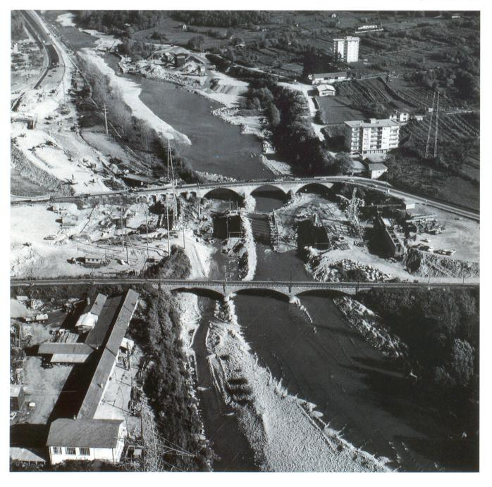
I cavi da precompresso sono del tipo BBRV CC 2350. Come d'uso alla fine degli anni sessanta la teoria classica delle tensioni ammissibili è servita da base per i calcoli di dimensionamento. Solo nello studio del precompresso si è analizzato il comportamento ultimo della struttura.
