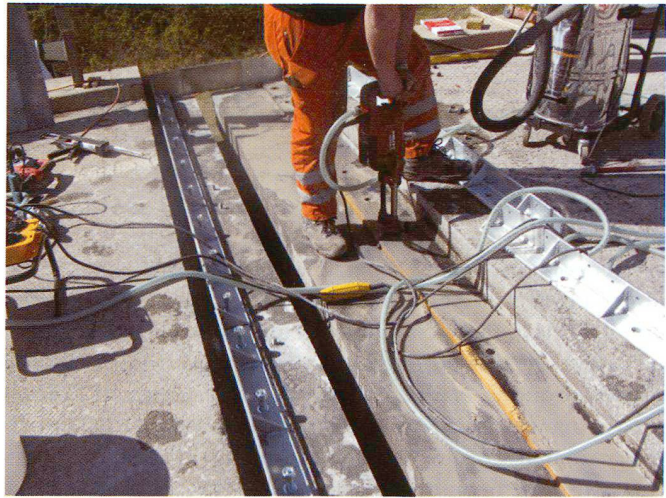
Intervento specialistico. Sostituzione giunto transizione
