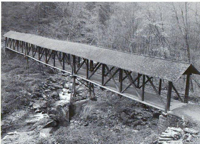
Ponte in legno di Curtina
