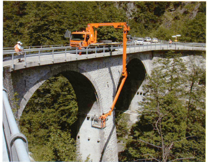
Ispezione con veicolo navicella
