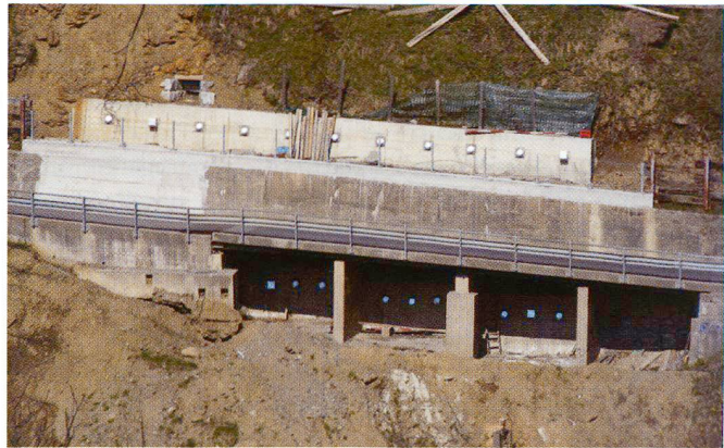
Intervento specialistico. Consolidamento pendio
