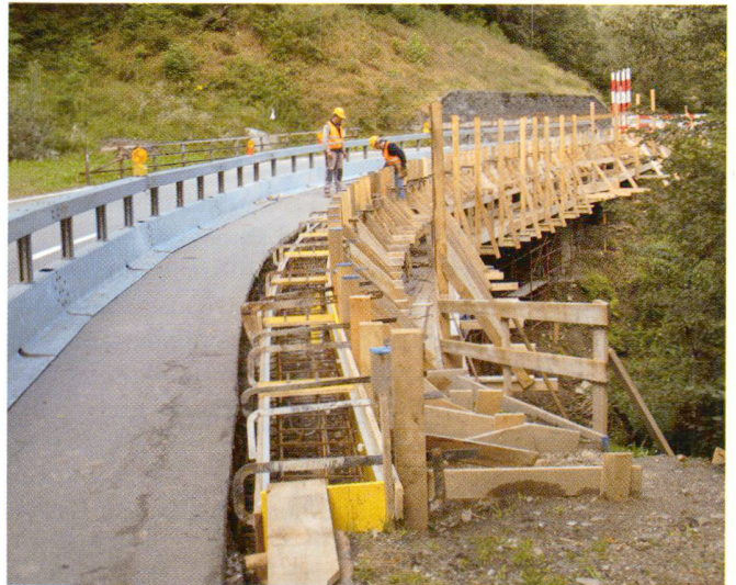
Intervento di manutenzione. Rifacimento cordolo
