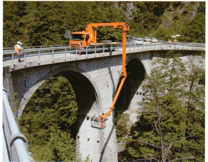
Ispezione con veicolo navicella
