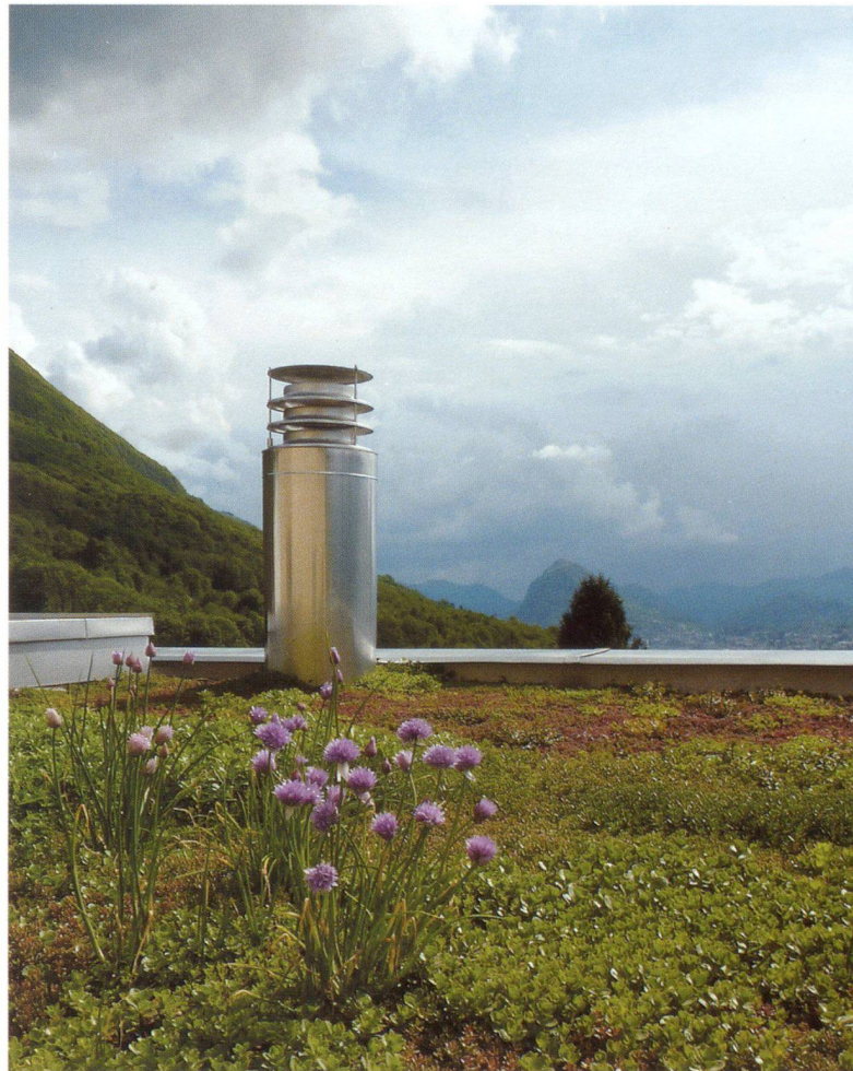
Esempio di tetto verde estensivo (foto E. Sassi)
