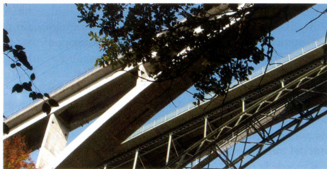
Ponte di Schwarzwasser (BE): costruito nel 1882, il ponte presenta un arco in acciaio con una campata di 120 metri, realizzata mediante chiodatura. Nel 2005 la corsia ferroviaria è stata ampliata e ristrutturata con elementi prefabbricati in cemento armato.
