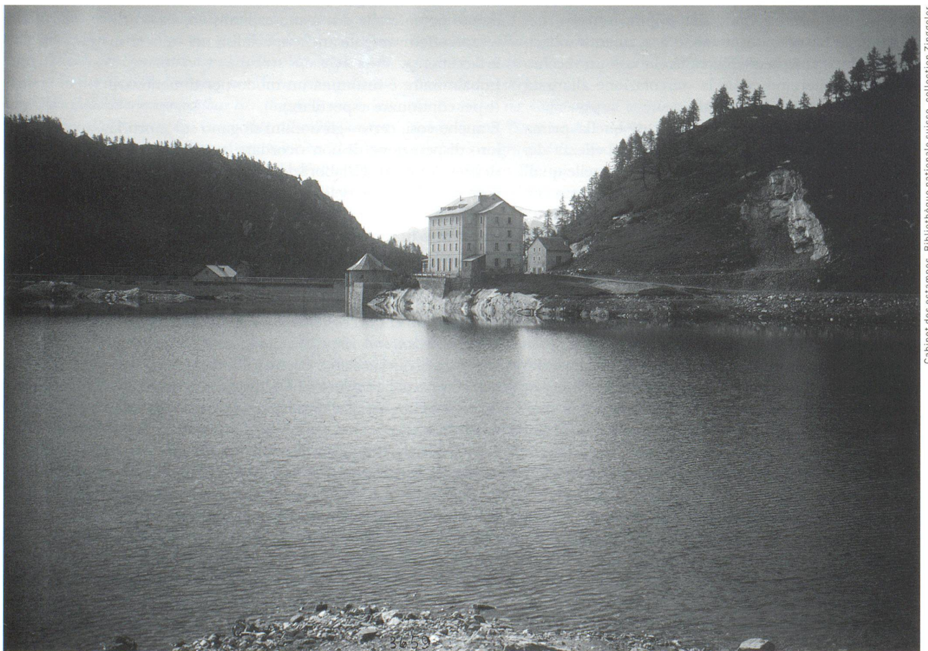
Veduta parziale del Lago Ritom con l'ex-Hotel Lombardi. Nel 1951 l'albergo è stato demolito ed il sedime sommerso.
