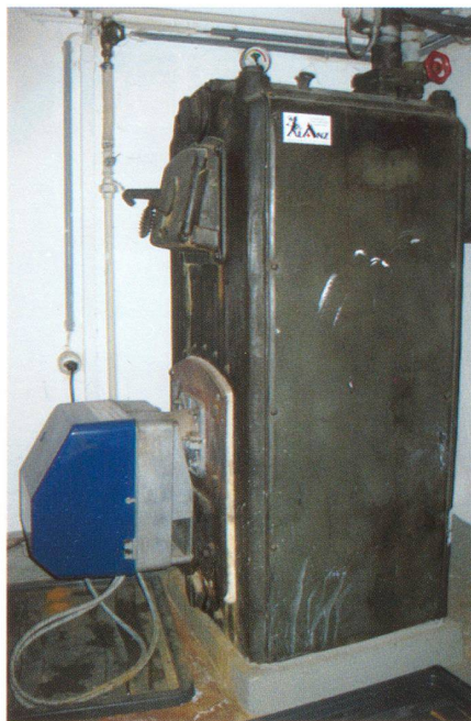
I vecchi riscaldamenti a gasolio occupano molto spazio e perdono calore. I moderni riscaldamenti a parete presentano un ingombro nettamente inferiore e quindi liberano spazio disponibile.
