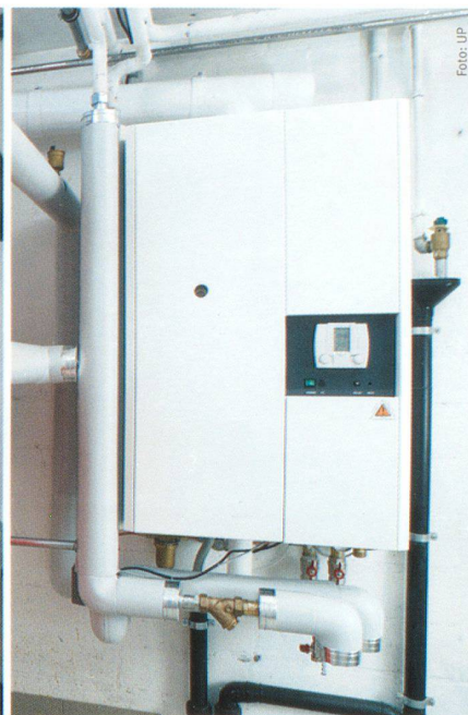
I vecchi riscaldamenti a gasolio occupano molto spazio e perdono calore. I moderni riscaldamenti a parete presentano un ingombro nettamente inferiore e quindi liberano spazio disponibile.
