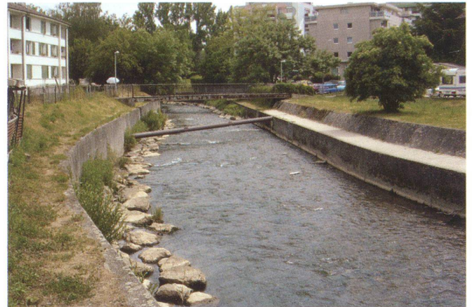
Intervento prima e dopo la rinaturalizzazione del Versoix nei pressi della nuova passerella
