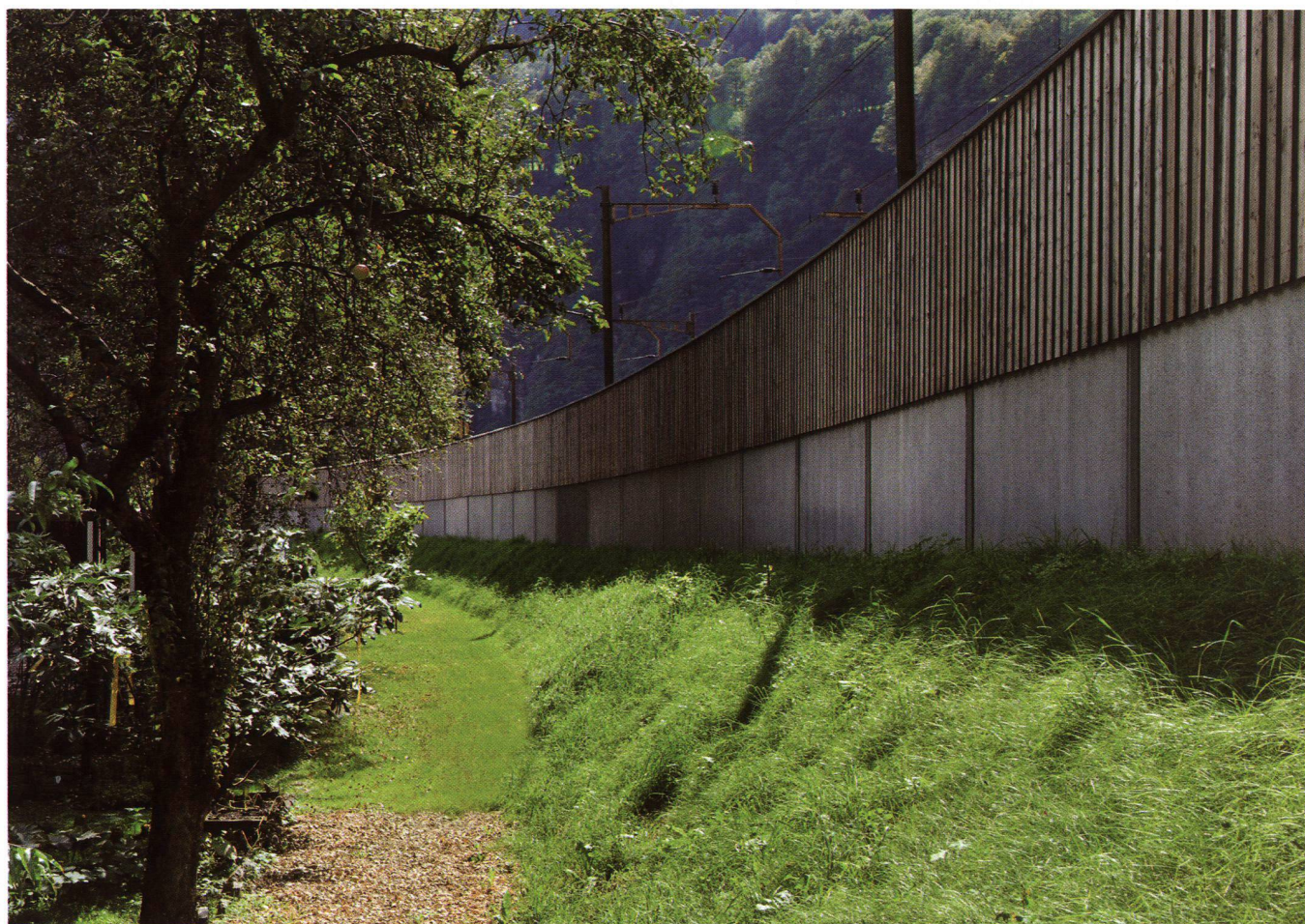
La «parete fonica standard»: zoccolo in cemento, pannello in legno con tavole di larice verticali. I profili verticali in acciaio sono nascosti nell'incastro tra le pareti.
