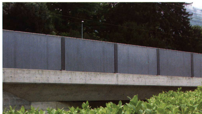
Bellinzona, manufatto con pannelli in calcestruzzo, esterno
