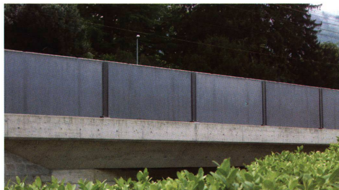
Bellinzona, manufatto con pannelli in calcestruzzo, esterno
