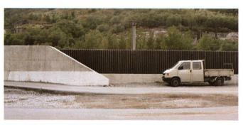
Quando il rivestimento fonoassorbente si appoggia al muro di sostegno esteso a lunga distanza come transizione altimetrica, il suo disegno di superficie si configura come limite territoriale e paesaggistico. L'unitarietà dell'intervento può essere realizzata con pannelli in cemento lavato standard, montati senza giunti apparenti
