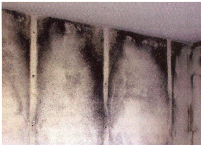
Muffa dietro un rivestimento di parete isolato
