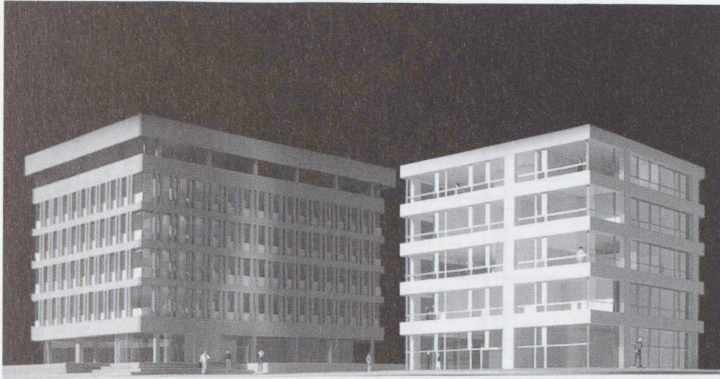
Il nuovo fabbricato con a lato l'edificio esistente di Camenzind e Brocchi
