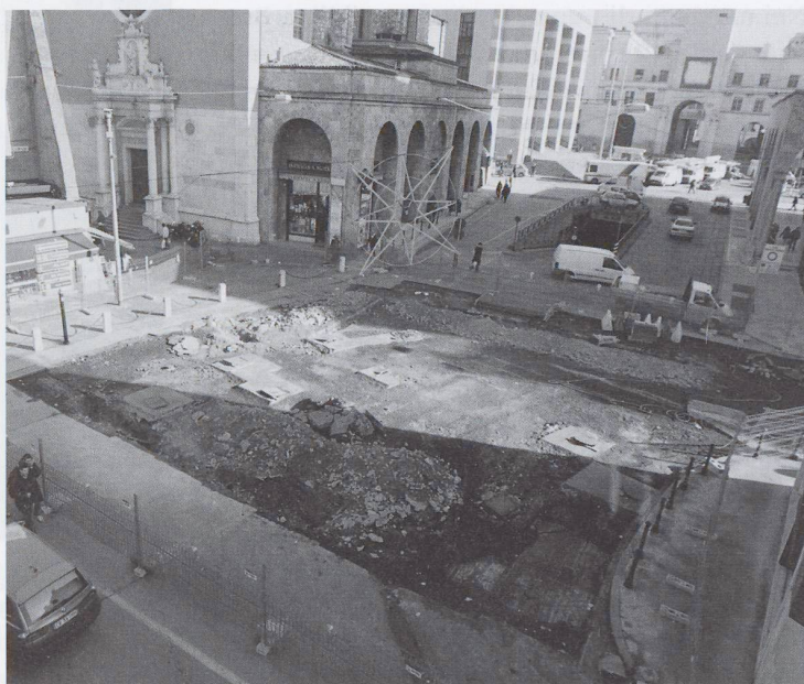
Fig. 9 – Esecuzione dello scavo per la stazione Volta in centro a Brescia Fig. 10 – Lavori nel cantiere in via Verdi
