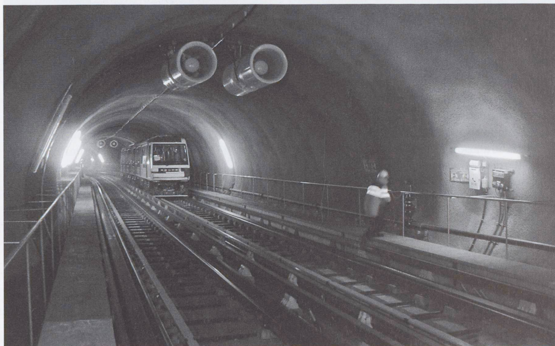
Fig. 6 - La tratta Formi-Vennes durante le prove incendio. Sulla destra è visibile una postazione di soccorso con segnaletica, telefono, estintore e idrante.
