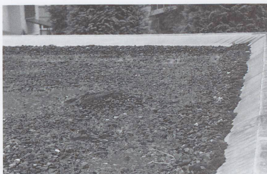
Fig. 2 – Il ritiro dimensionale dei tetti in PVC diffusi in Ticino dopo gli anni '70 è stato all'origine di sostituzioni premature di interi tetti piani. La ricerca AES ha dimostrato come la durata di vita media di una ventina di questi rivestimenti è stata attorno a 22 anni (Intervento dell'ISAAC al congresso International Conference on durability of Building Materials and Components, Lione 17-20 aprile 2005).
