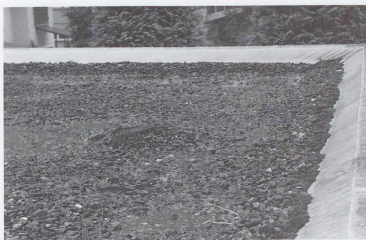
Fig. 2 – Il ritiro dimensionale dei tetti in PVC diffusi in Ticino dopo gli anni '70 è stato all'origine di sostituzioni premature di interi tetti piani. La ricerca AES ha dimostrato come la durata di vita media di una ventina di questi rivestimenti è stata attorno a 22 anni (Intervento dell'ISAAC al congresso International Conference on durability of Building Materials and Components, Lione 17-20 aprile 2005).
