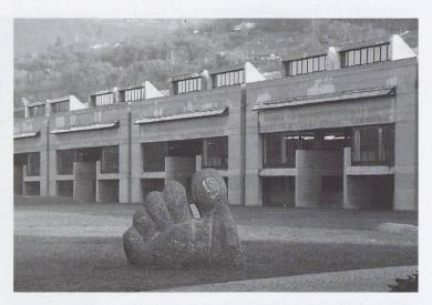
Fig. 5 – La scuola media di Morbio Inferiore, arch. Mario Botta: costruzione massiccia tradizionale
