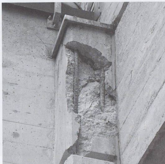
Fig. 3 – Il problema della carbonatazione del beton è il fenomeno che riduce la durata di vita prevista per questo materiale introdotto nella costruzione in quanto ritenuto più longevo di altri materiali tradizionali quali la muratura intonacata, p.es.
