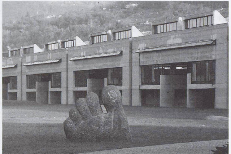
Fig. 5 – La scuola media di Morbio Inferiore, arch. Mario Botta: costruzione massiccia tradizionale
