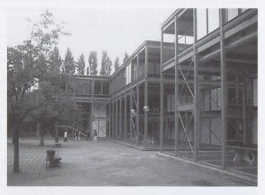
Fig. 6 – La scuola media di Losone degli architetti L.Galfetti e L.Vacchini: costruzione prefabbricata in acciaio
