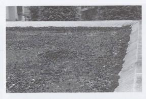
Fig. 2 – II ritiro dimensionale dei tetti in PVC diffusi in Ticino dopo gli anni '70 è stato all'origine di sostituzioni premature di interi tetti piani. La ricerca AES ha dimostrato come la durata di vita media di una ventina di questi rivestimenti è stata attorno a 22 anni (Intervento dell' ISAAC al congresso International Conference on durabilità of Building Materials and Components, Lione 17-20 aprile 2005).
